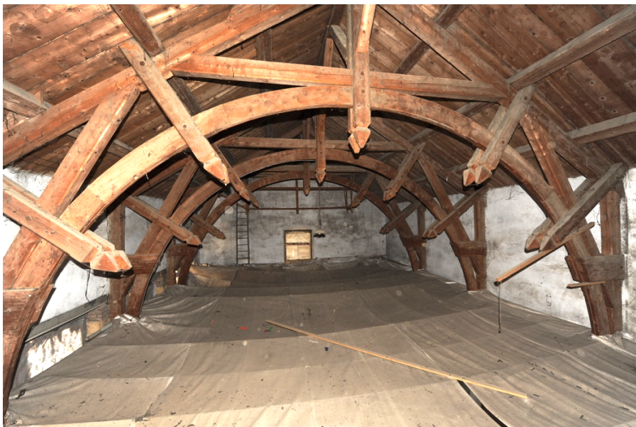
La spectaculaire charpente « à la Philibert de l'Orme » du local des pompes, actuellement dissimulée par un film géotextile bidim.
