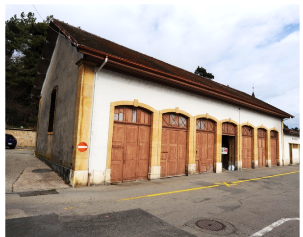
Volumétrie générale du local des pompes à incendies et local de gymnastique, en grande partie financé à l'époque par le propriétaire du château de Grandson.
