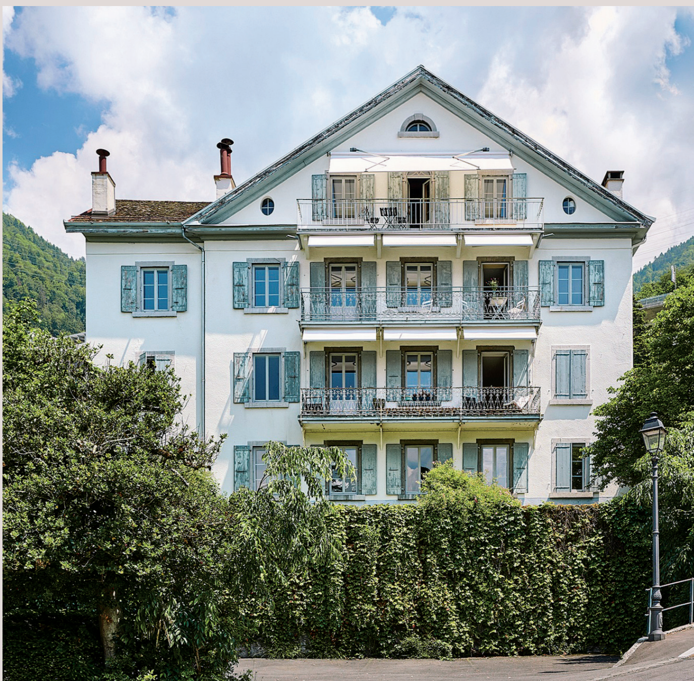
Fig. 1. La maison «Les Platanes» à Veytaux, en note 3 au recensement architectural du canton de Vaud. Etat en 2023.
