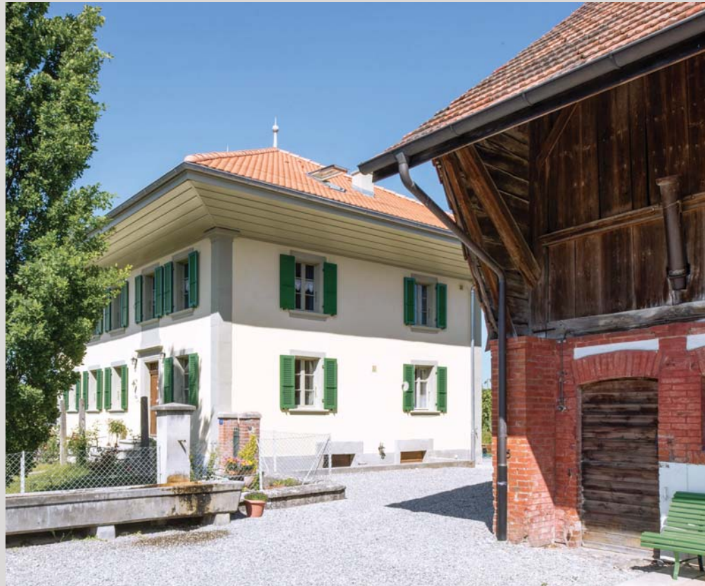
Maison villageoise à Villarepos (FR), 1867. Restauration et assainissement énergétique par l'Atelier d'architecture espaces & environnement, Fribourg.
