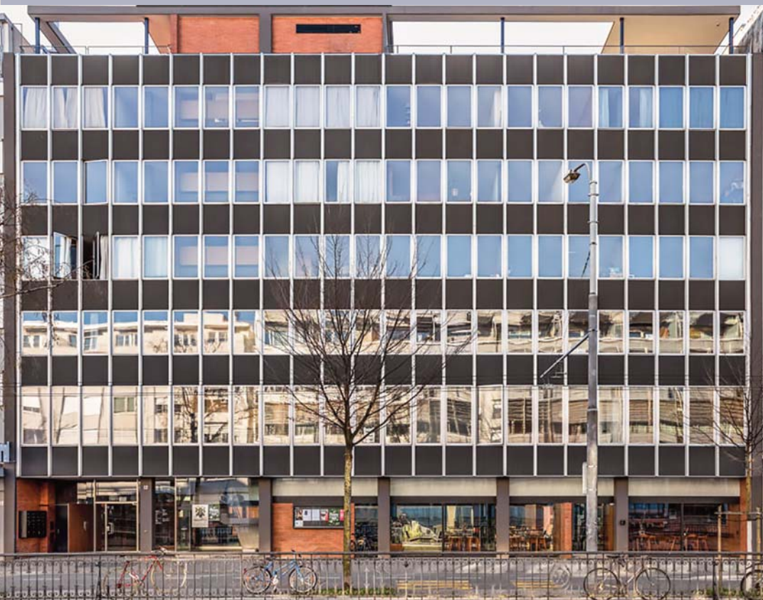
Maison Farel (1959) Bienne. Assainissement réalisé par le bureau 0815 Architekten, Bienne.
